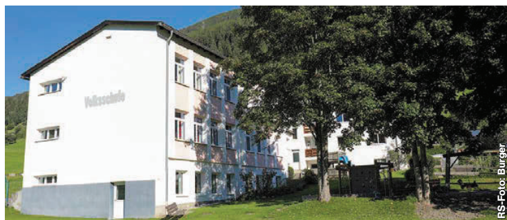
Die Volksschule und der Kindergarten Leins sind zwar stetig gepflegt worden, jedoch stehen einige Verbesserungen an, um den heutigen Standards zu entsprechen und der ländlichen, aber gut besuchten Volksschule mehr Möglichkeiten zu bieten.
